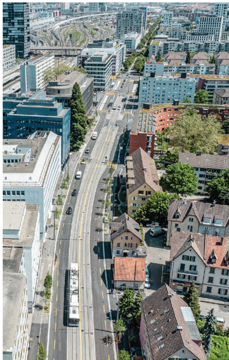
Die Tramlinie des Limmattals misst 13,4 Kilometer und führt von Zürich-Altstetten bis Killwangen.
