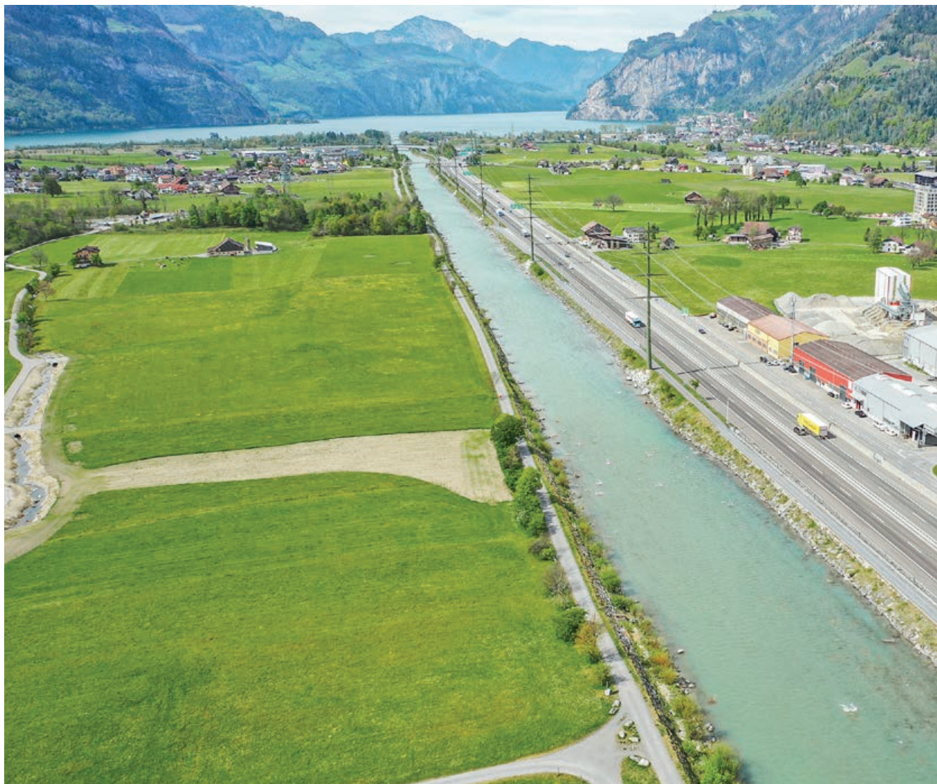
Bei Altdorf im Kanton Uri kann die Reuss bei Hochwasser über die Autobahn A2 abgeleitet werden.
