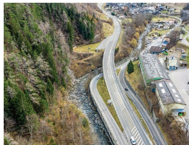
Grosser St. Bernhard: Die Orsières-Brücke führt über die Dranse d'Entremont.
