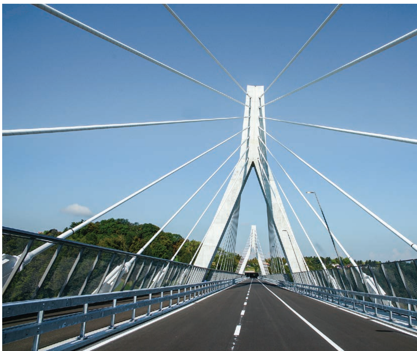
Die 851 Meter lange Poya-Brücke in Freiburg führt über die Saane und entlastet das Altstadtquartier bei der Kathedrale vom Durchgangsverkehr.
