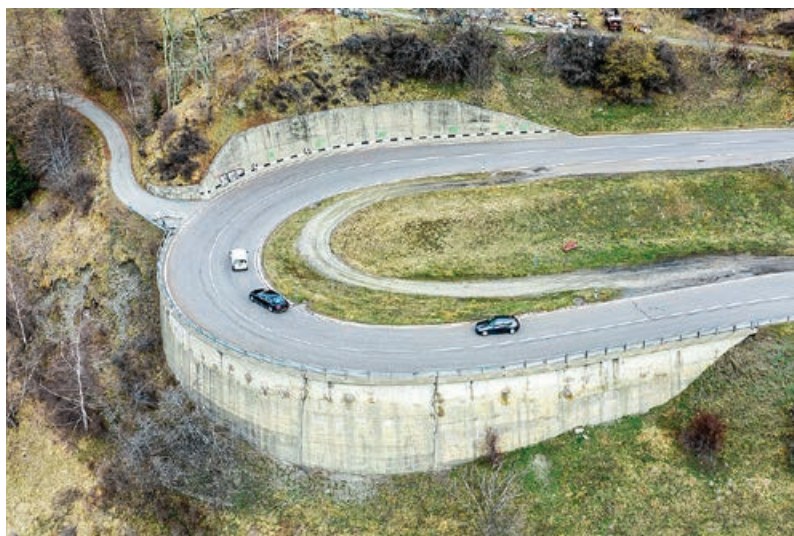
Eine Stützmauer bei Rive-Haute bei Orsières auf der Strecke zum Grossen St. Bernhard.
