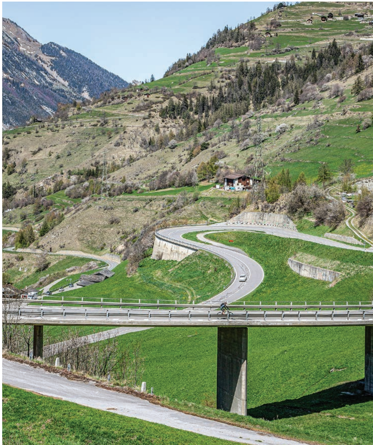
Die Rive-Haute-Brücke oberhalb von Orsières.
